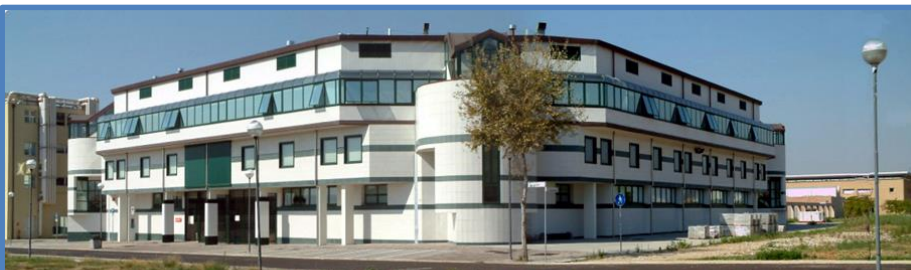
Edificio P5- CAMPUS Sesto Fiorentino
